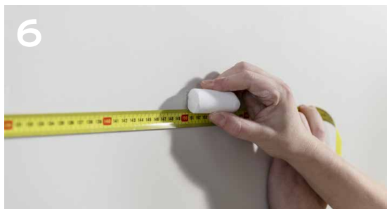
6 Miss ab und markiere die horizontalen und vertikalen Linien mit Kreide.
