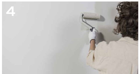
4 Trage sie mit der Rolle auf. Sie dient als Grundschicht.
