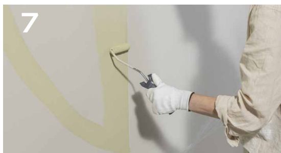
7 Zeichne die Umriss des Designs freihändig vor und trage die zweite Farbe auf.
