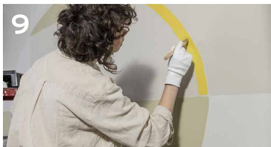
9 Verwende zum Ausfüllen des Umrisses einen Pinsel.
